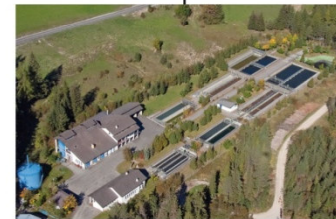
ARA SOMPUNT Pedraces
